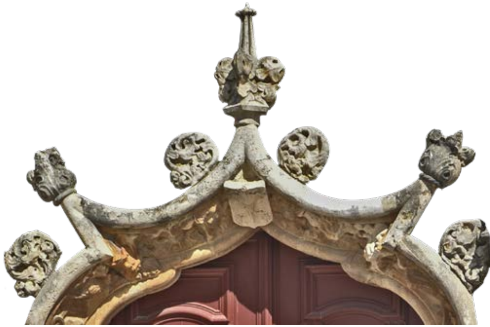
Detalhe do arco do portal
