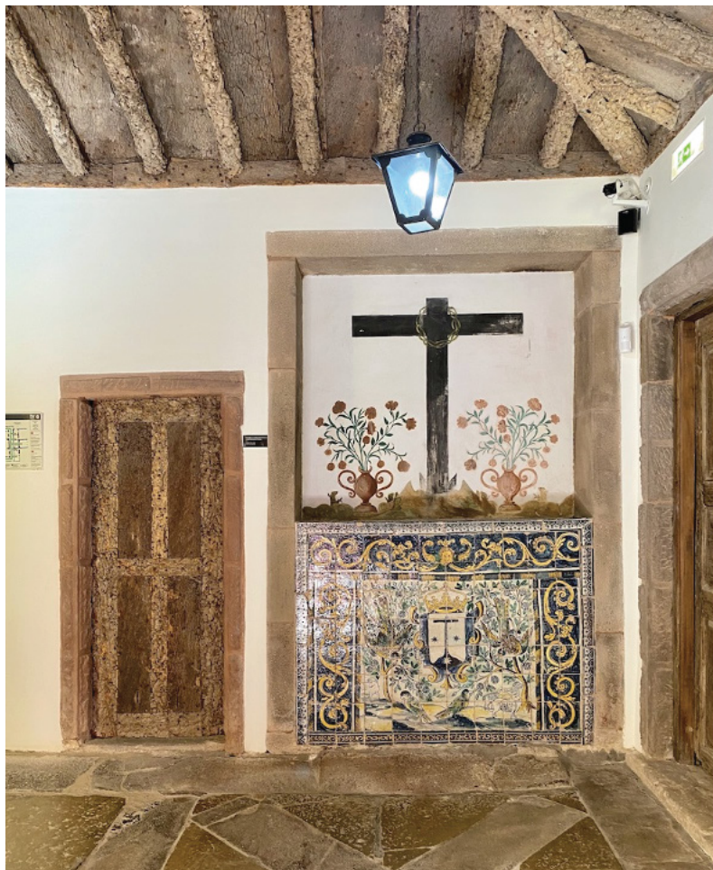
Teto e porta em cortiça, pintura a fresco e painel de azulejos
