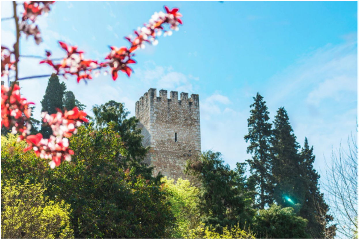
Torre do castelo
