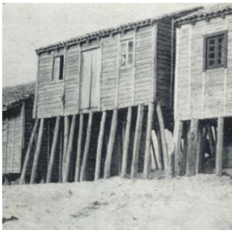
Palheiros de madeira construídos sobre estacas
