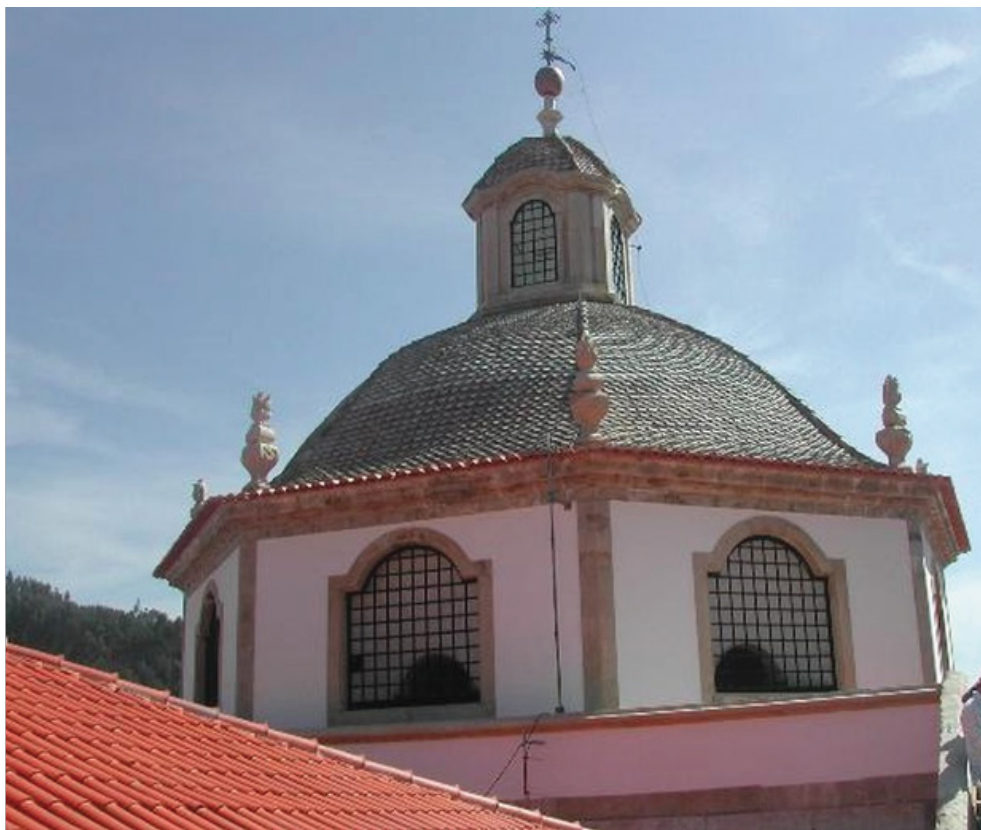
Zimbório (cúpula) do Mosteiro
